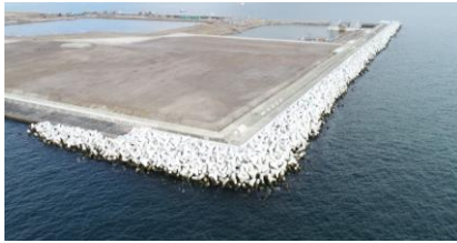
神戸沖処分場南面護岸工事
