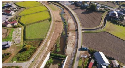
樋谷川改修工事
